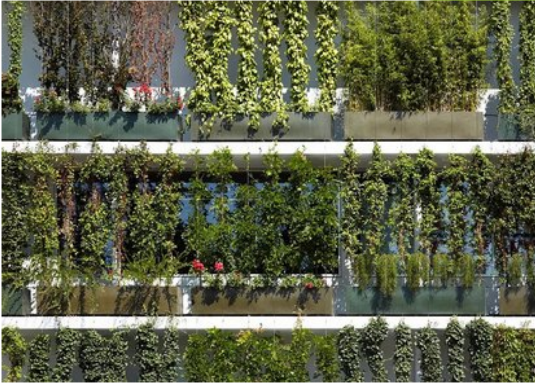
Sodronyos futtatórendszerrel árnyékolt épület
