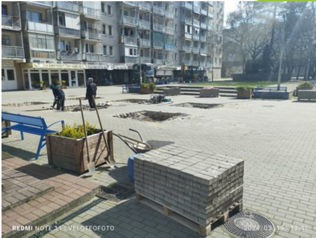
Fényképmelléklet 12. fotó: Faültetés a korábban teljesen lekövezett Vörösmarty tér térkőburkolatába, Miskolc, 2024.03.19. (Fotó: Fülep Teofil VeloTeoFoto.net)
