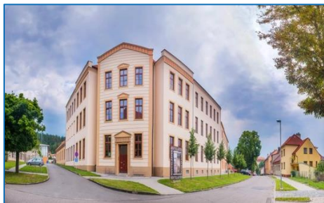
Foto 1 - Gesamtansicht des Gebäudes
