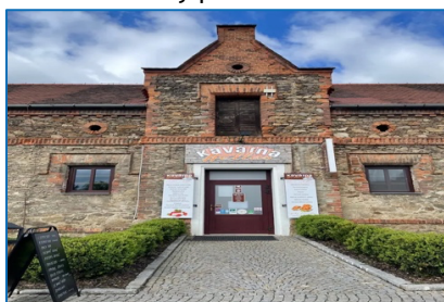
Foto 1 - celkový pohled na budovu
